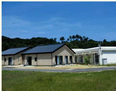
本体施設と渡り廊下で併設されました
