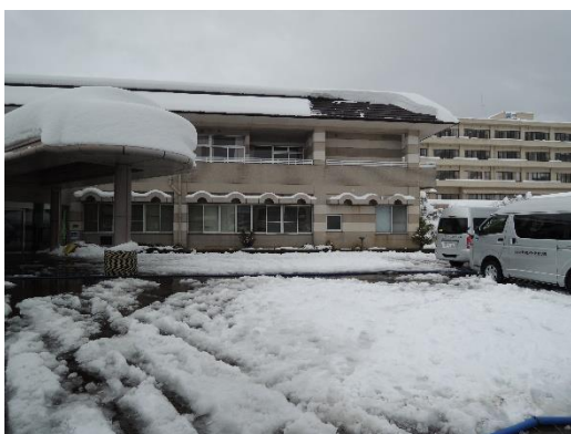
施設玄関前は、水を出す消雪設備はあるものの、雪の降り方が激しすぎて、追いつかない状況 (R3,1/12)
